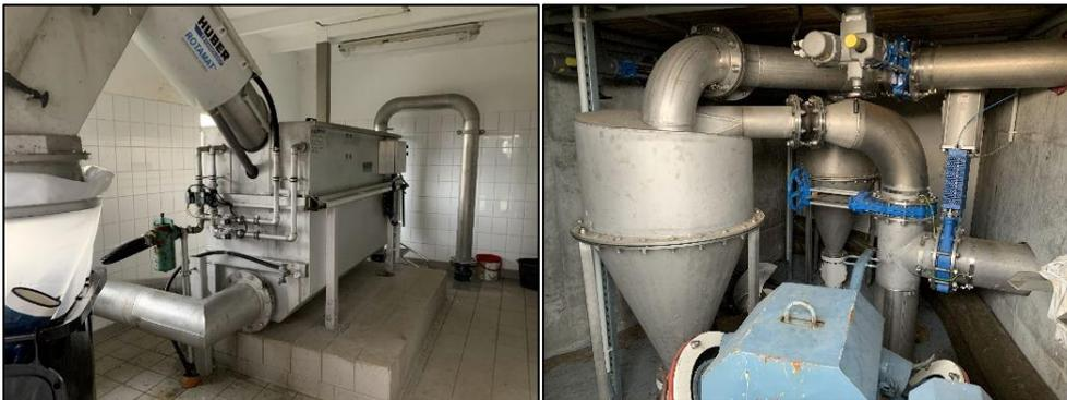
**Abbildung 3-2: Mechanische Reinigung (Rechen und Hydrozyklone) KA Nebel**
